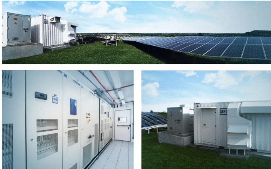
Fotografia 4 – Eletrocentro centralizado WEG instalado em container
