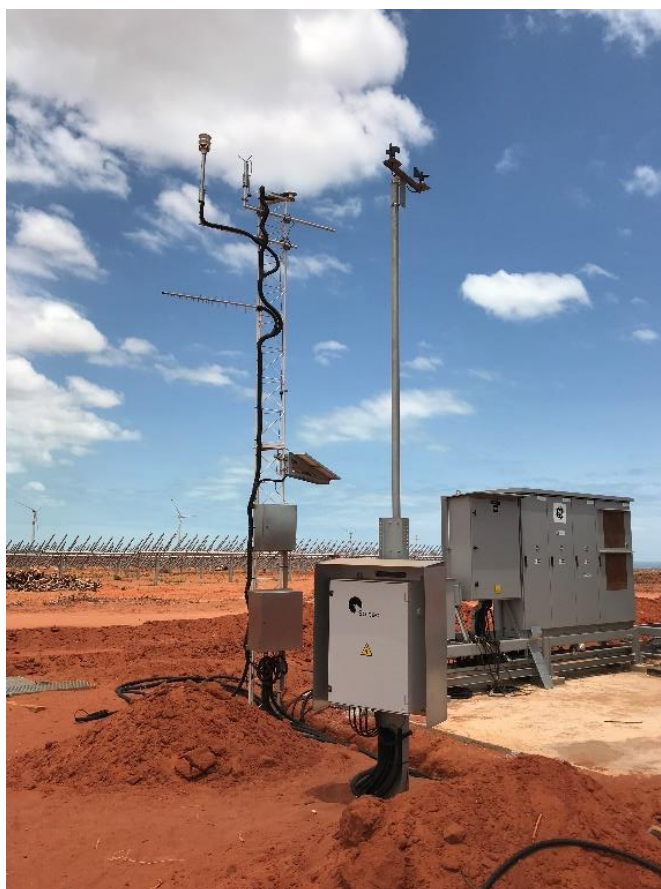
Fotografia 27 – Instalação meteorológica e solarimétrica por inversor
