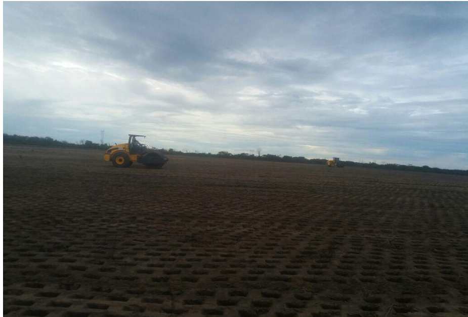
Fotografia 11 – Terraplanagem e compactação do terreno
