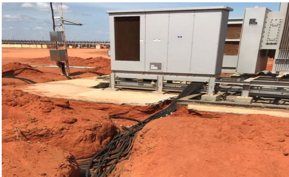
Fotografia 24 – Cabos que vêm das strings e chegam ao inversor (ITS GE)
