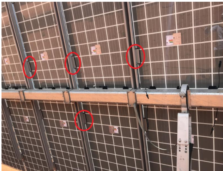
Fotografia 20 – Detalhes dos pontos de fixação do módulo na mesa
