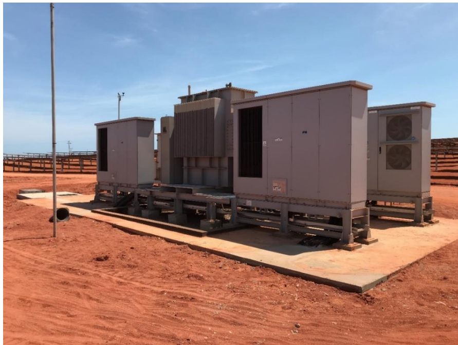
Fotografia 5 – ITS GE de 4.4 MW (inversor fixado na estrutura metálica skid )
