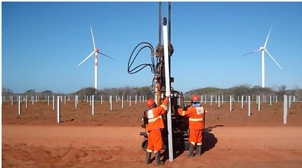
Fotografia 14 – Marcação e fixação das estacas
