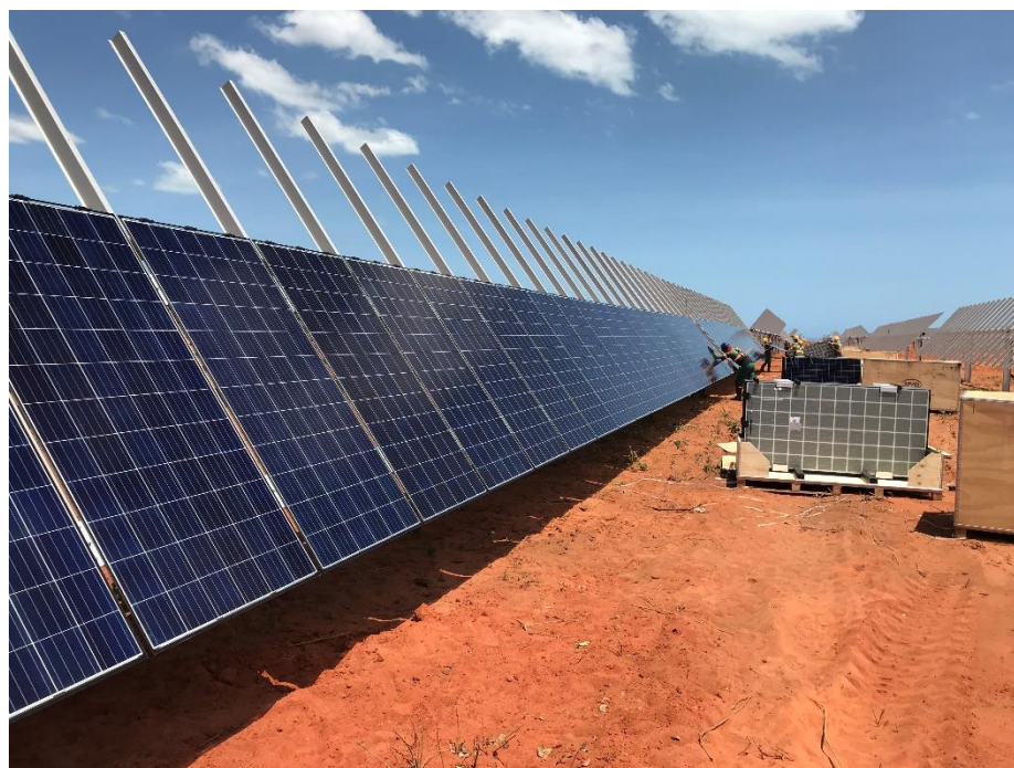
Fotografia 15 – Instalação dos módulos em estrutura com tracker posição de 0^\circ a -60^\circ
