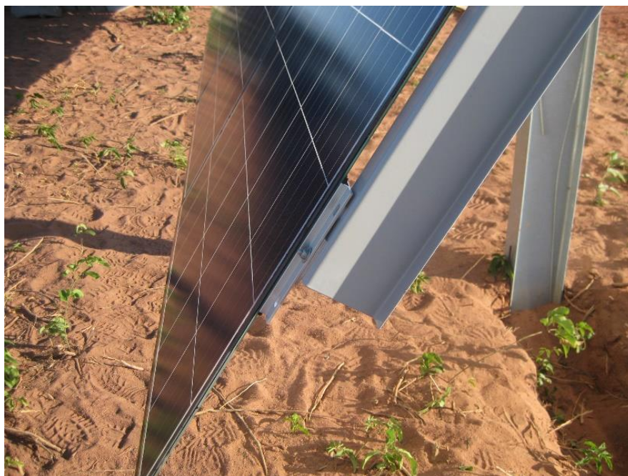
Fotografia 21 – Detalhes dos pontos de fixação do módulo na mesa
