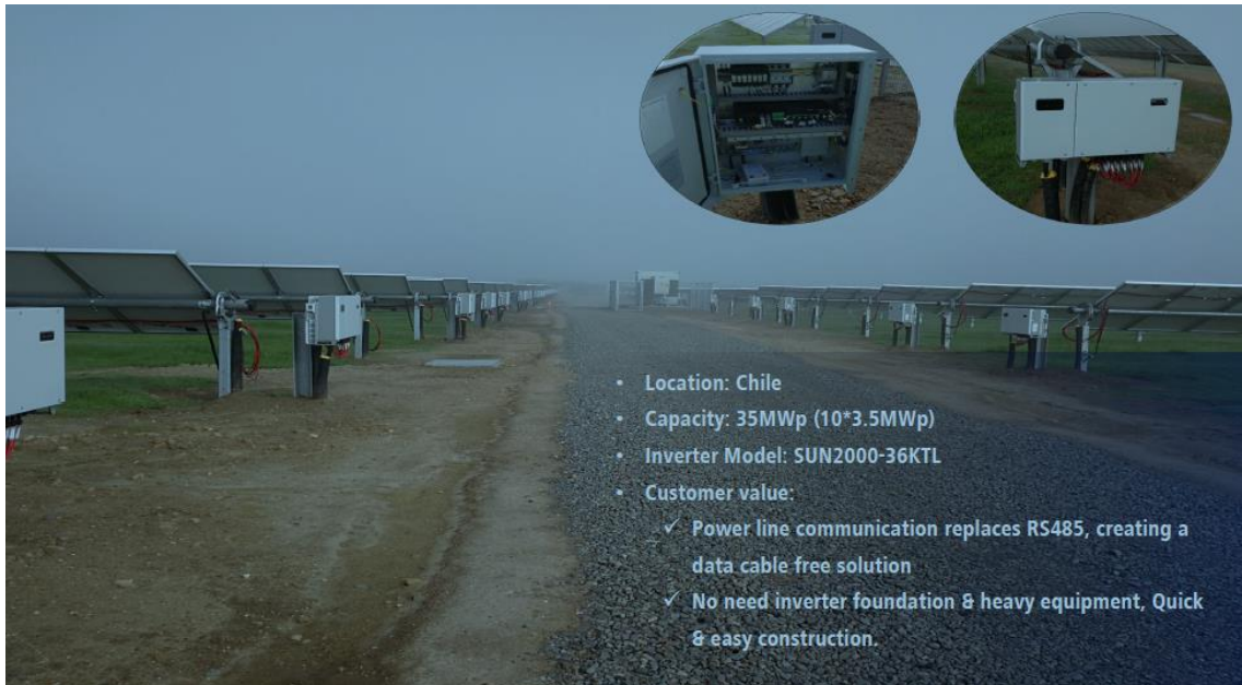
Fotografia 3 – Inversor descentralizado Huawei Fusion Solar – Sun 2000-36KTL
