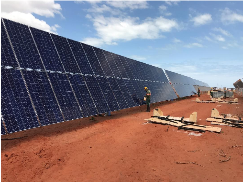
Fotografia 16 – Instalação dos módulos em estrutura com tracker
