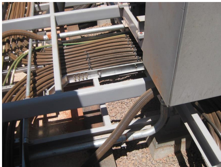
Fotografia 26 – Instalação de cabos no inversor provenientes das strings/array
