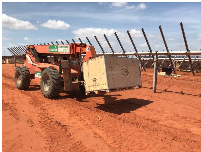
Fotografia 18 – Transporte dos módulos para o local de instalação
