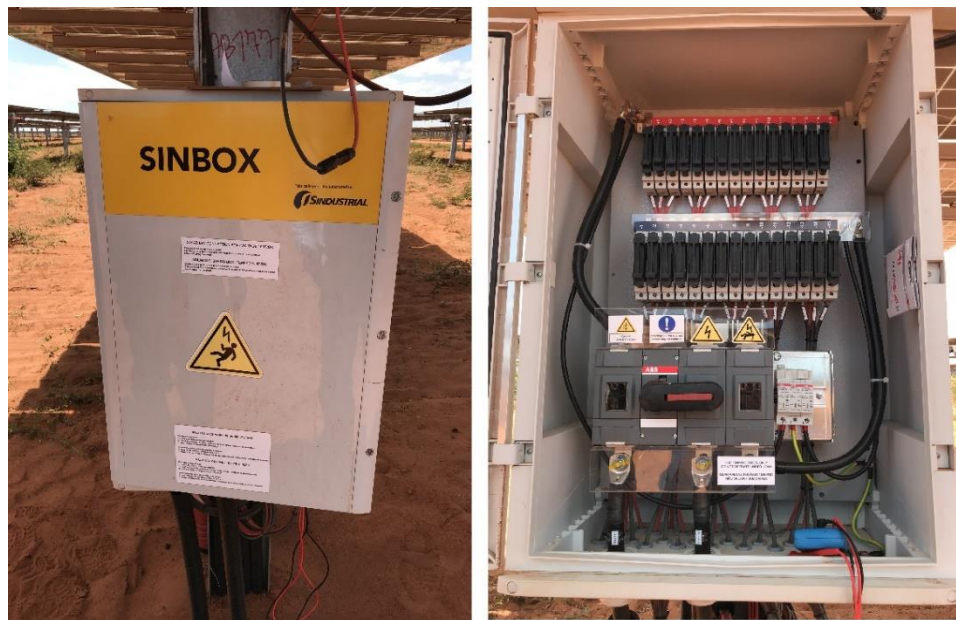
Fotografia 6 – String box Sindustrial (detalhes do material, sinalização de perigo e componentes de proteção)
