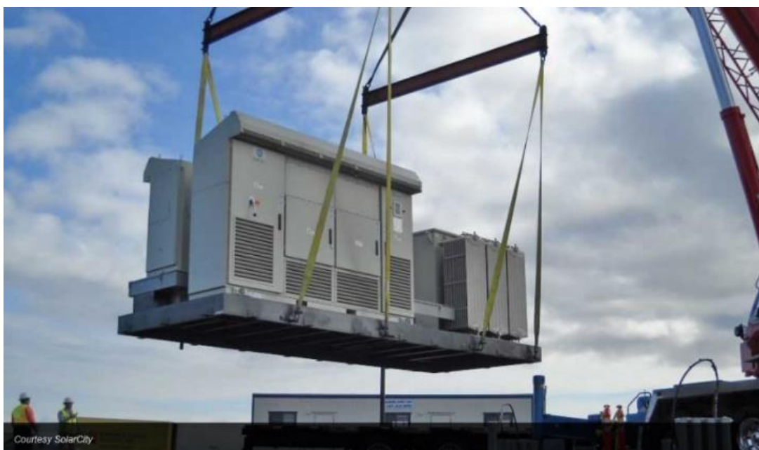
Fotografia 25 – Instalação com guindaste do inversor GE sobre a base
