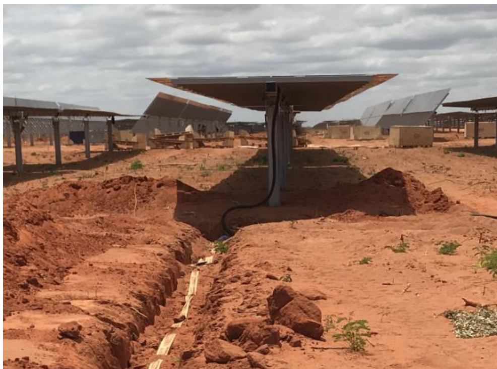
Fotografia 23 – Construção das valas para lançamento das strings e arrays até o inversor
