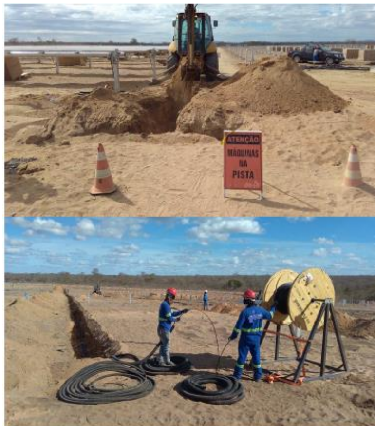
Fotografia 12 – Construção de valas e lançamento de cabos
