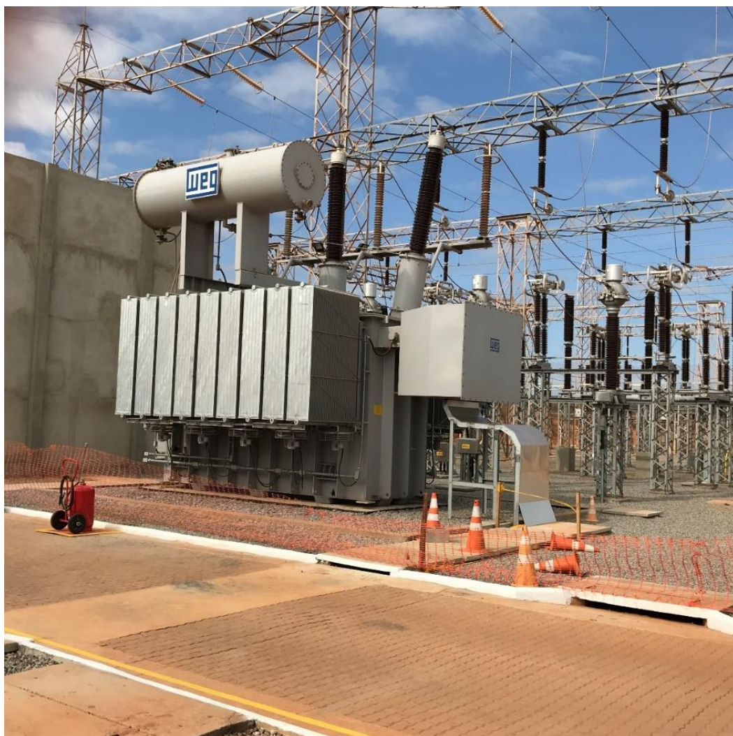
Fotografia 7 – Subestação elevatória de MT/AT de usina fotovoltaica
